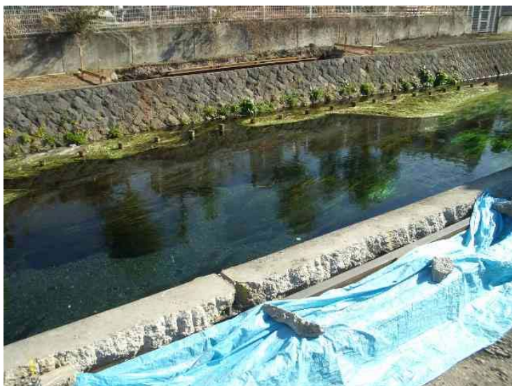
右岸、左岸のH構打ち込み後の状況
